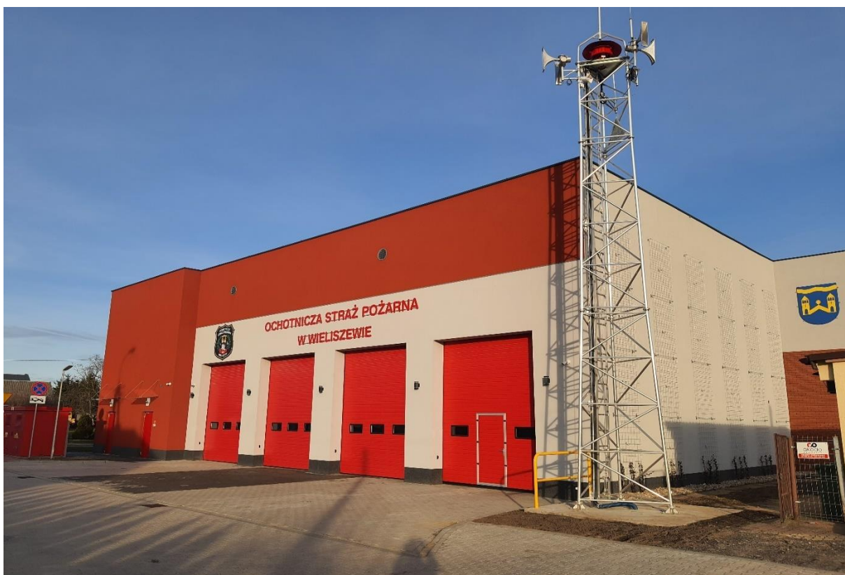
Nowa remiza Ochotniczej Straży Pożarnej w Wieliszewie.
