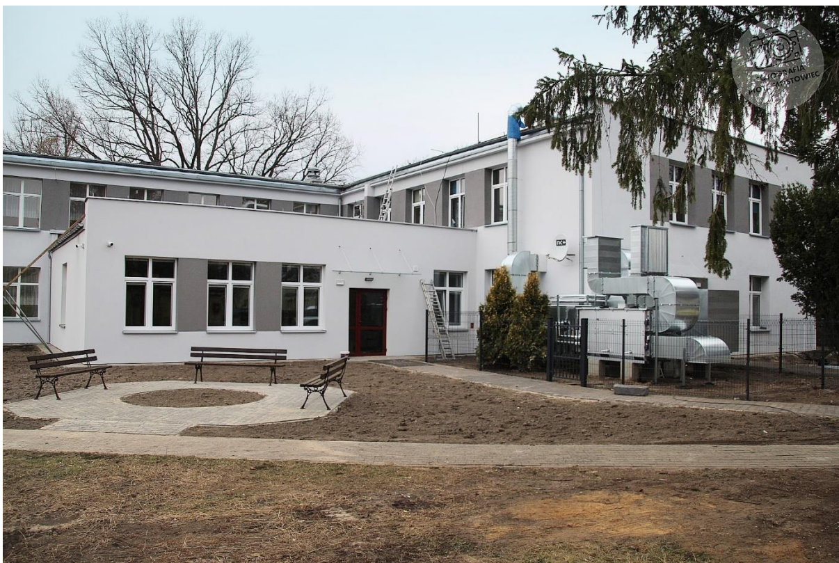
Budynek Szkoły Podstawowej w Skrzyszewie.
