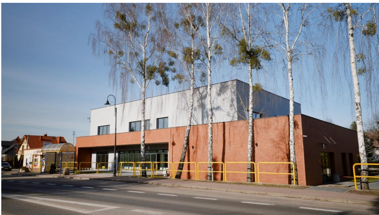
Budynek Centrum Społeczno-Kulturalnego w Wieliszewie.
