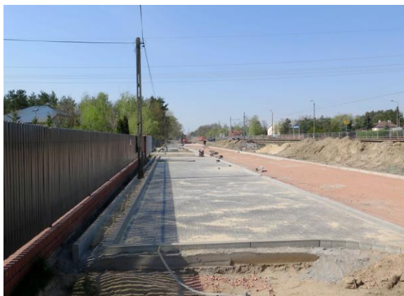
Budowa parkingu „Parkuj i Jedź” przy stacji PKP w Michałowie-Reginowie
