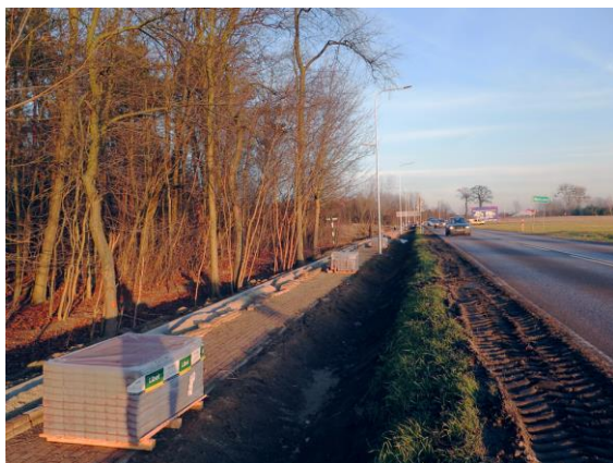
Budowa ścieżki rowerowej Poniatów-Wieliszew
