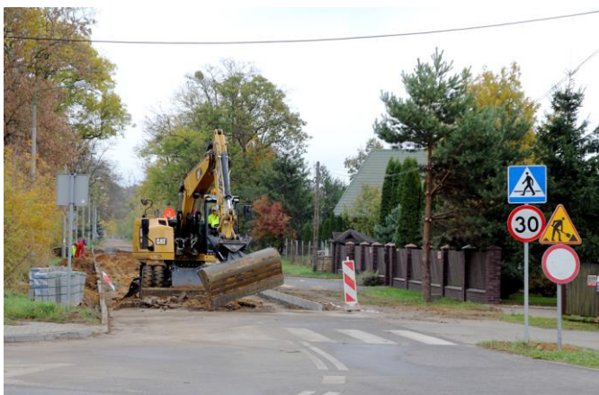
Przebudowa ul. Zacisze w Janówku
