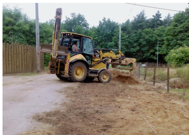
Budowa drogi gminnej – ul. Leśnej w Wieliszewie
