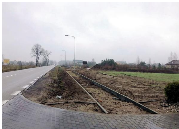
Budowa chodnika w Krubinie
