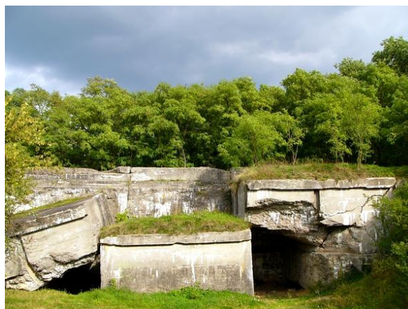
Fort żelbetonowy w Janówku
