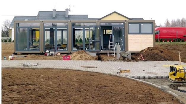
Olszewnica Nowa – budynek w trakcie budowy
