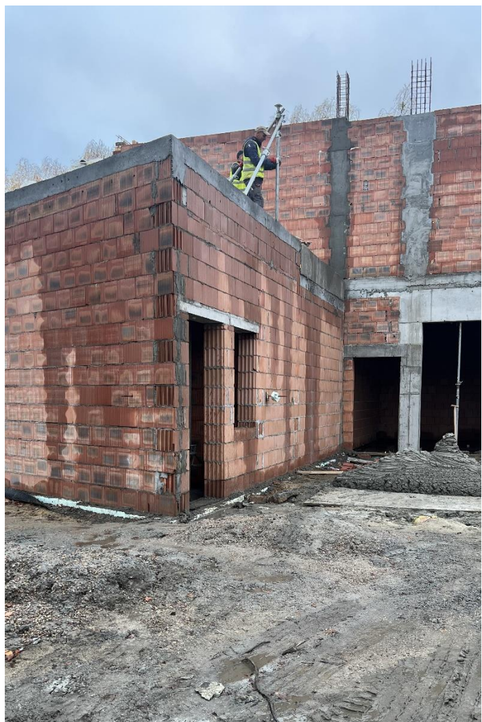
Fotografia 14 | Budowa Centrum Społeczno-Kulturalnego
