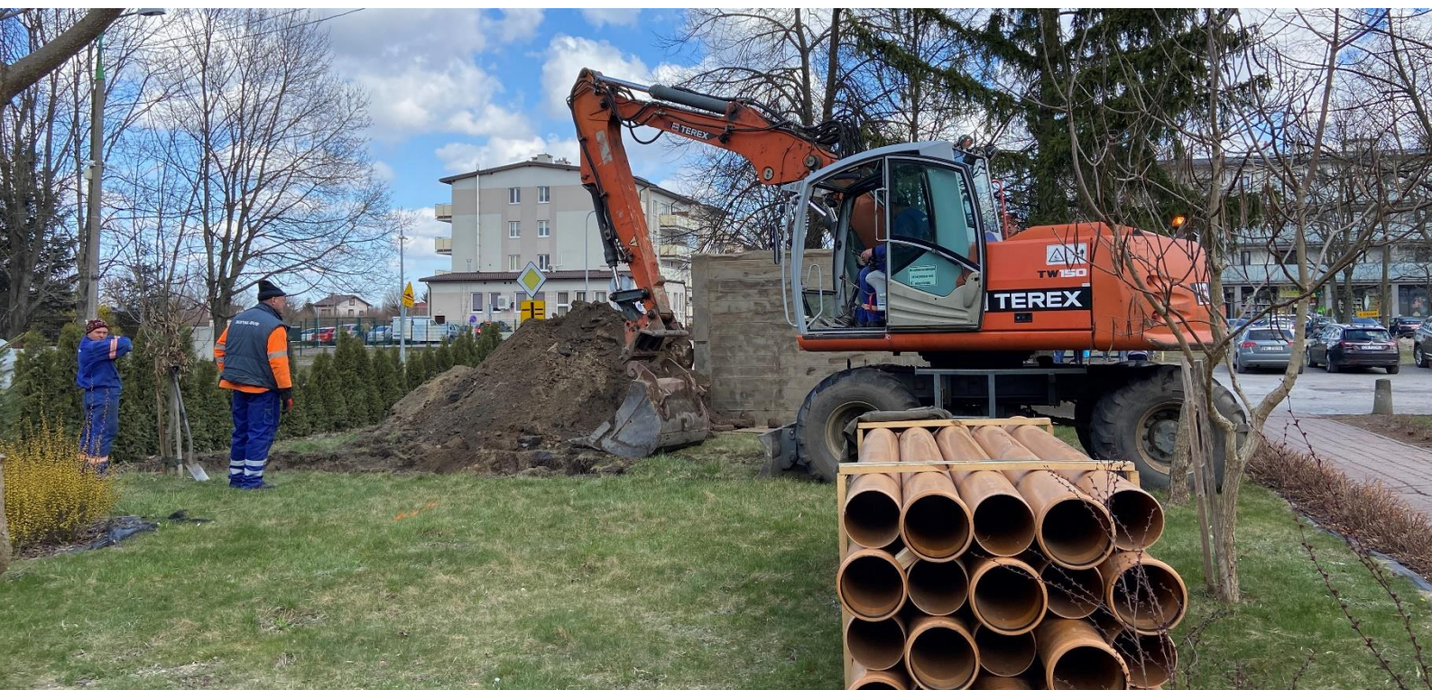
Fotografia 13 | Przebudowa kanalizacji sanitarnej na obszarze otoczenia Urzędu Gminy Wieliszew
